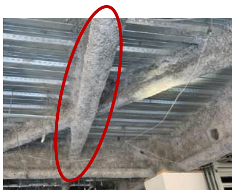
多くの建材に使用されていた有害な「アスベスト」
