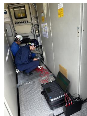
動力制御盤での診断作業の様子
