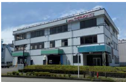
■テクニカルセンター外観
