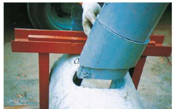
既設管と塩ビ管の接合状態 取付部組立状況
