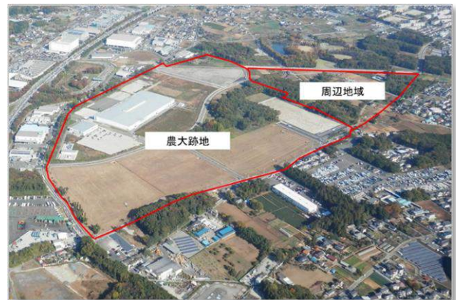
SAITAMAロボティクスセンター（仮称）整備予定地
