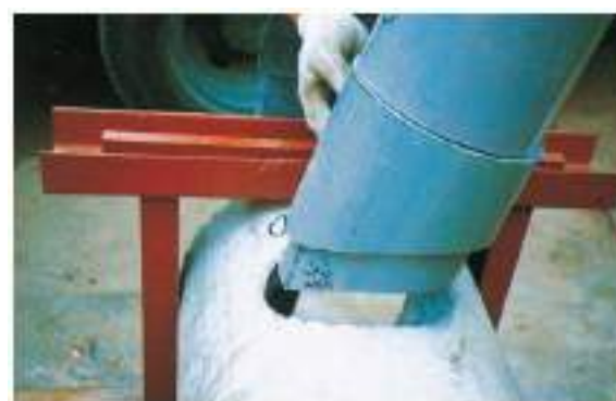
既設管と掘り管の接合状態 取付部組立状況
