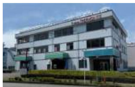
■テクニカルセンター外観
