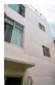
■外断熱防水防災工事
