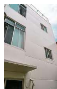
■外断熱防水防災工事
