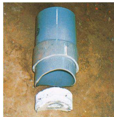
取付部回収コアの合せ加工
