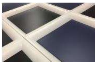
3_なまこ壁(漆喰)金属でパネル化
