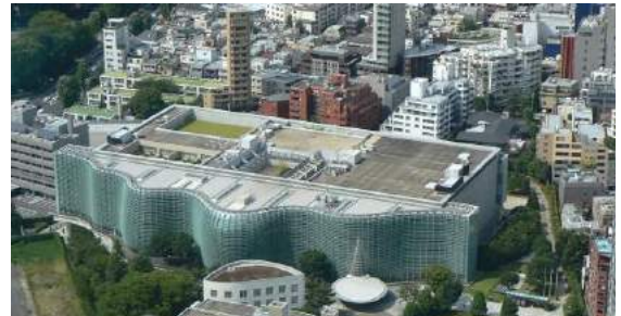
東京・六本木 K美術館 全面施工 2011 年度 年間削減電気量 220 万 kWh
