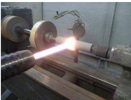
溶射による補修
