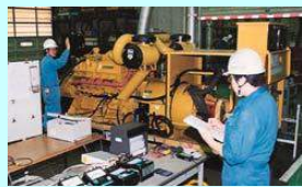
発電機の負荷テスト
