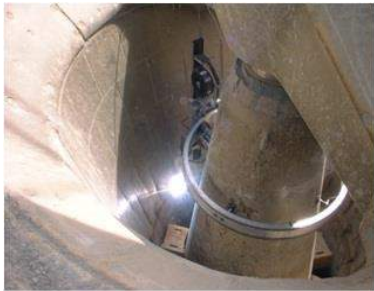
ジャイレトリークラッシャの現地再生
