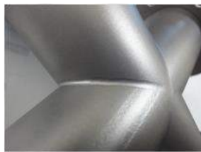
<チタン素材の溶接例>
