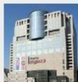
JR 八王子駅北口出口 正面
