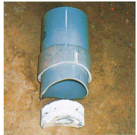
取付部回収コアの合せ加工
